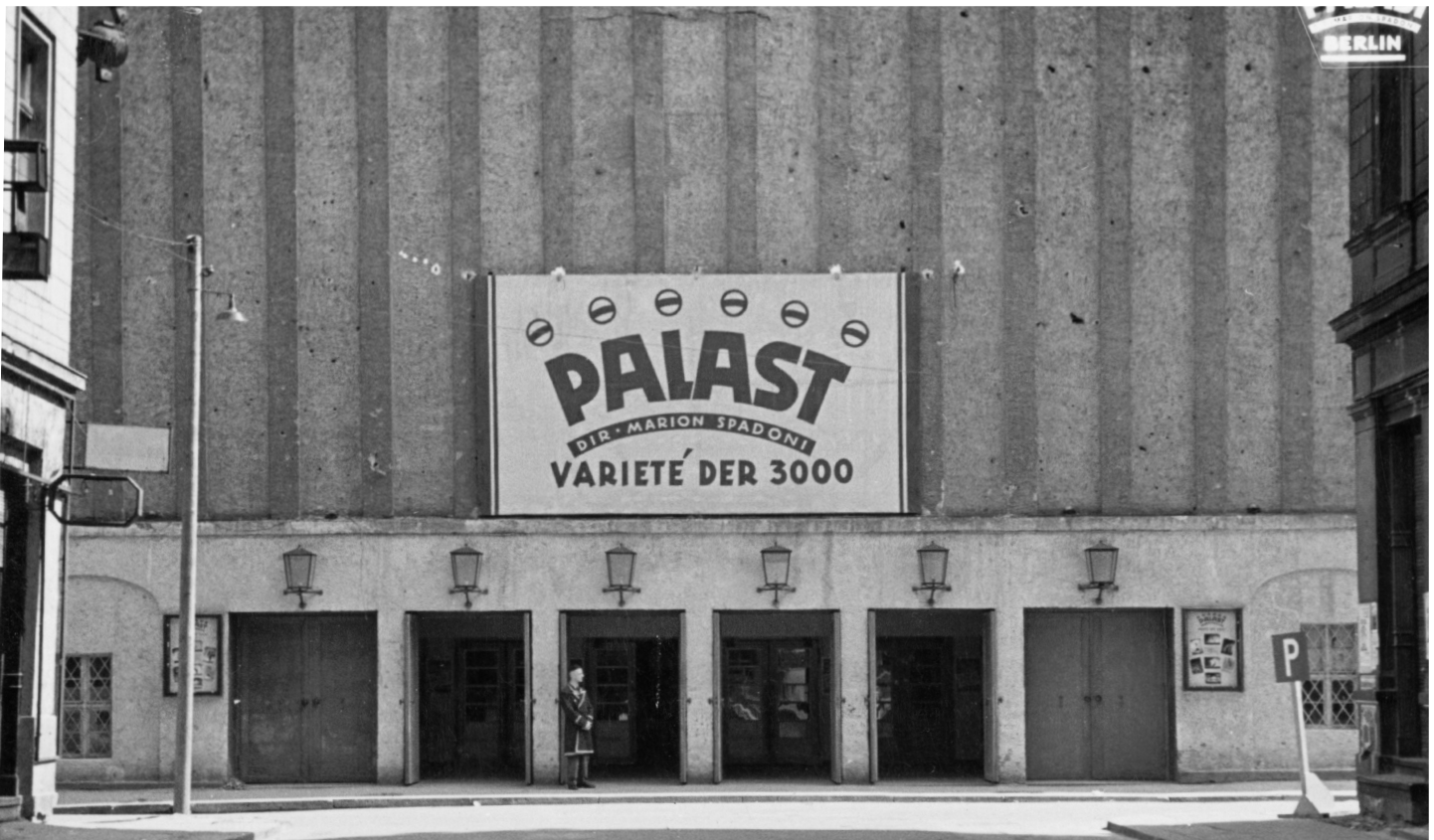
Haupteingang des Palast Varietés um 1946 – Granatensplitter stecken in der Fassade über den Türen
